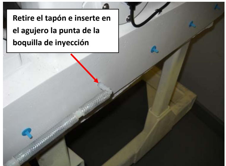
FIGURA 16 – PROCESO DE INYECCIÓN DE ADHESIVO
